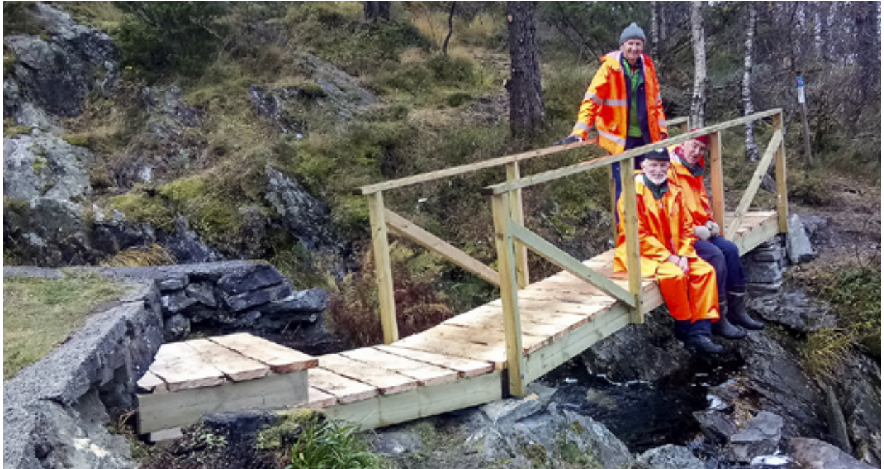
Broen ved Smådiket er ferdig.
