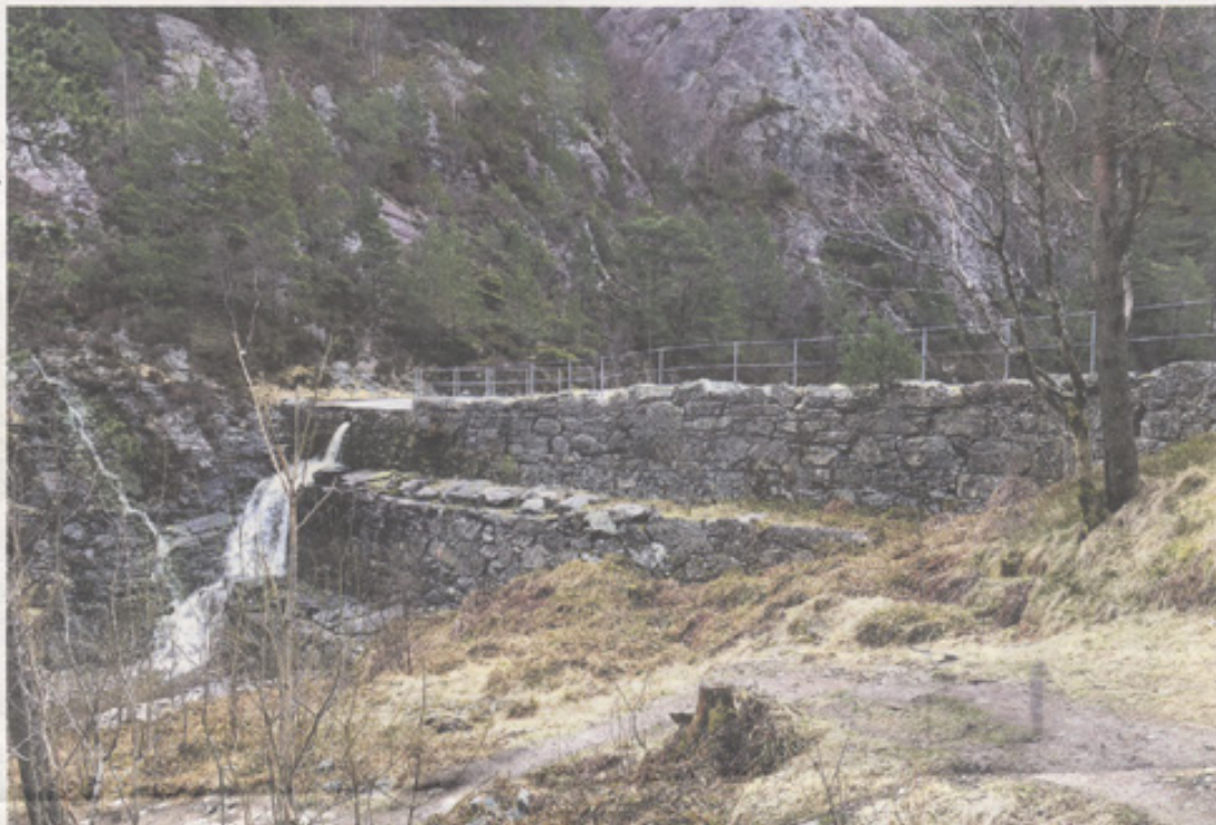
DENNE: Denne gamle demningen nord i Munkebotvatnet som trenger et skikkelig løft. Det bærer en viss usikkerhet om nøyaktig tidspunkt for den siste hevingen av denne demningen, men det kan ha vært på alle siste del av 1800-tallet. FOTO: RUNE ULRIK
