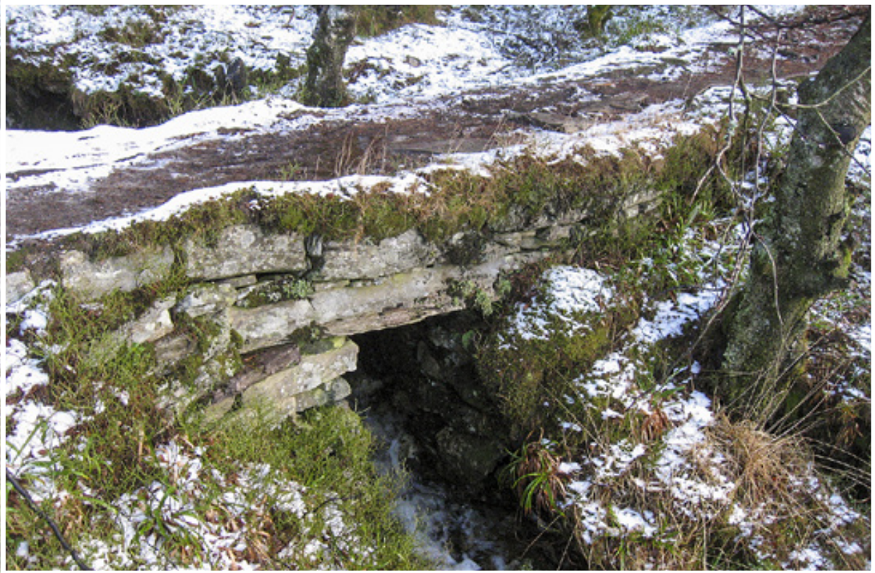
Stien har flere små broer. Denne ligger på flaten mellom Fjellstova og den nye Sherpa-trappen.
