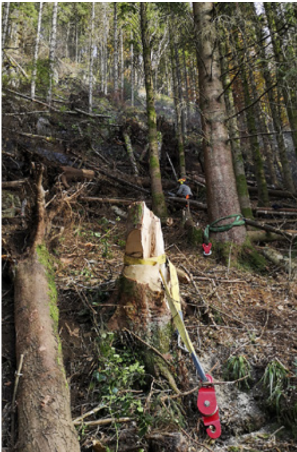
Sikring av vindfall på Hesteberget. Foto: ØS
