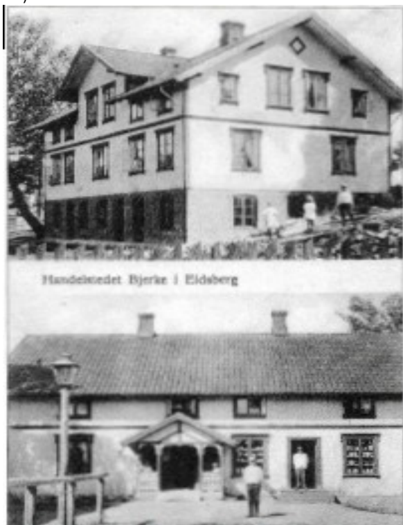
Prospektkort fra før 1910 av Bøndernes Hus -Bjerke -«Markusgården» Bildet er todelt. Øverste del sett fra sør-vest. Kjelleretasjen ule senere butikk. Nedre del sett fra øst med butikken dengang
