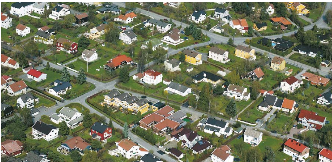
Fig. 3.1 Typisk småhusområde med flere bebyggelsesstrukturer, varierende bygningsvolumer og ulik takform.
