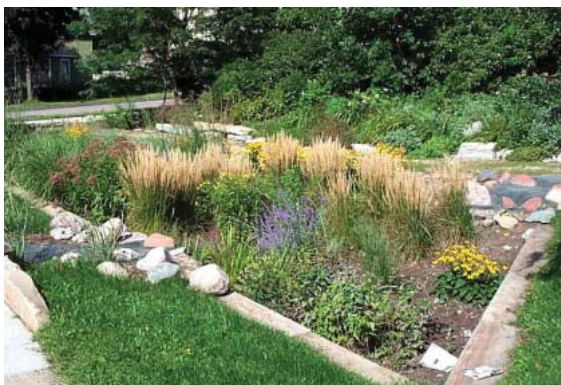
Fig.6.19 Eksempel på regnbed - vanninfiltrasjon.
