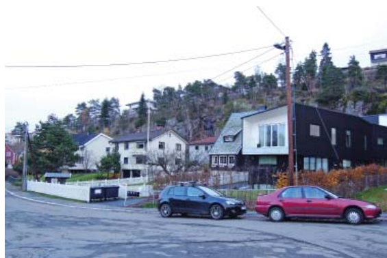
Fig.7.8 Tiltak som samspiller ved hjelp av bebyggelsesstruktur, skala og farger/ materialer, Myrerveien.
