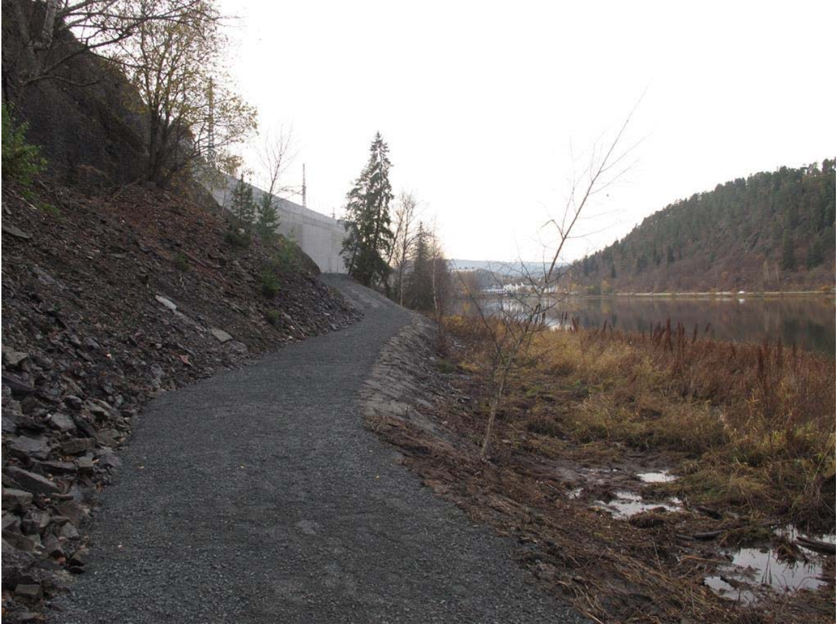
Figur 20. Ferdig bygd turveg langs Engervannet før oppsetting av gjerde. Foto: Rune Solvang. 29.10.2011.
