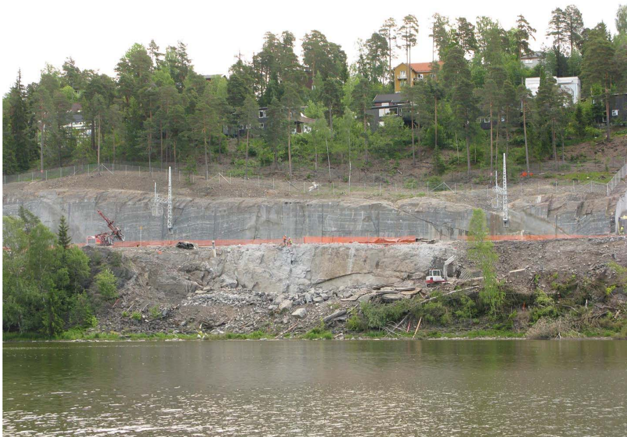
Figur 19. Anleggsarbeid 06.07.2009. Foto: Rune Solvang.
