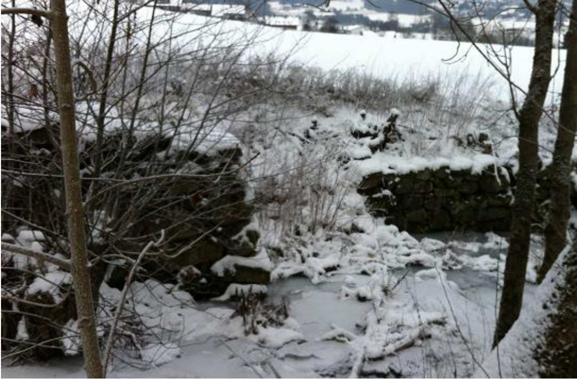
Fundamentrestene etter bekkekvernene er fremdeles markante
