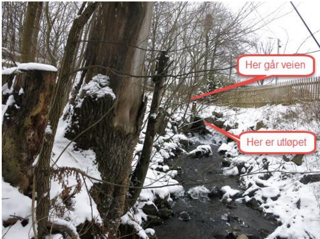
Rørråpningen sett nedenfor veien
