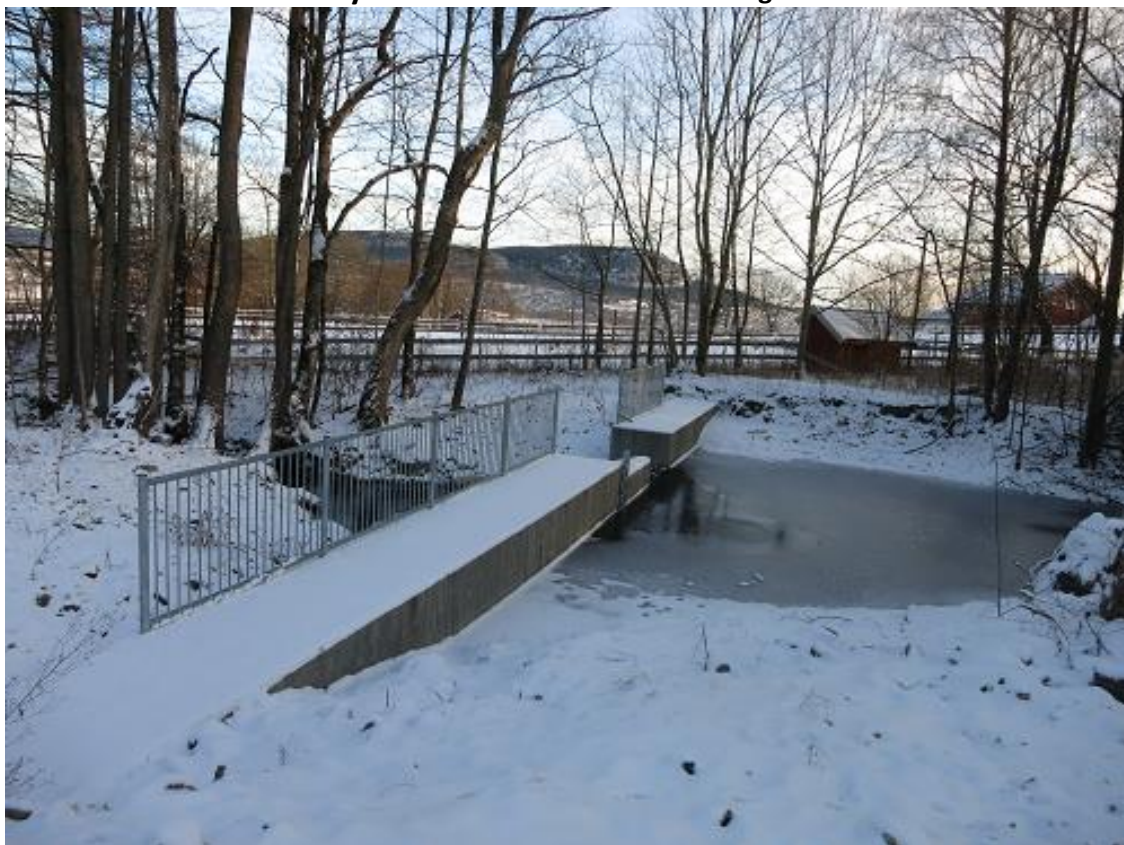
Demningen slik den ser ut etter i 2014 rehabilitering av Bærum kommune
