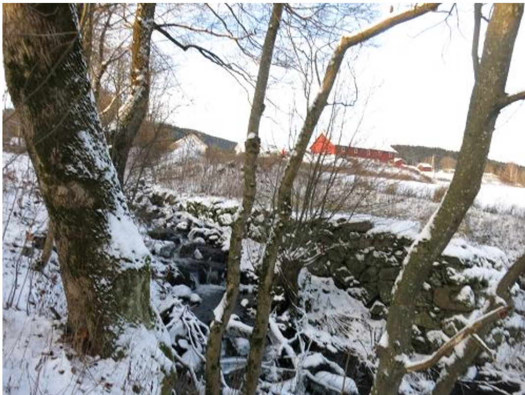
I øvre partiet av bekken nær nedre Horni, ligger rester av fundamentene til kvernhusene
