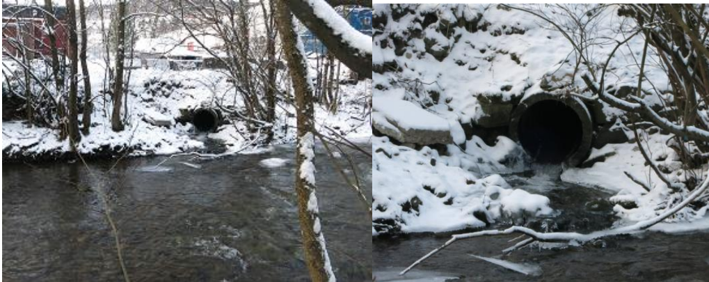
Rørtløpet i Isielva skaper vansker for fisk og ål når vannstanden er lav
