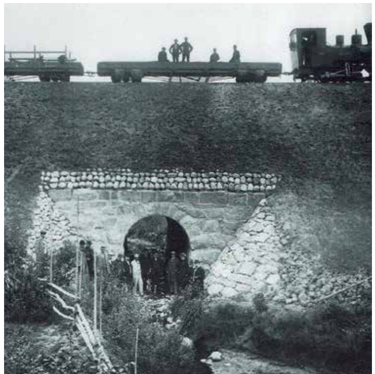
Kulverten ved Jødalsbekken var en imponerende konstruksjon da den stod ferdig 14. september 1896. Bildet er hentet fra boka Banen og Bygda .
