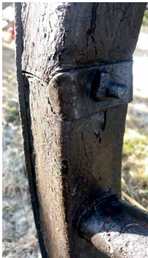
Disse to bildene viser eksempel på låsing av slitebane og segmenter med ett beslag i hver segmentskjøt.
