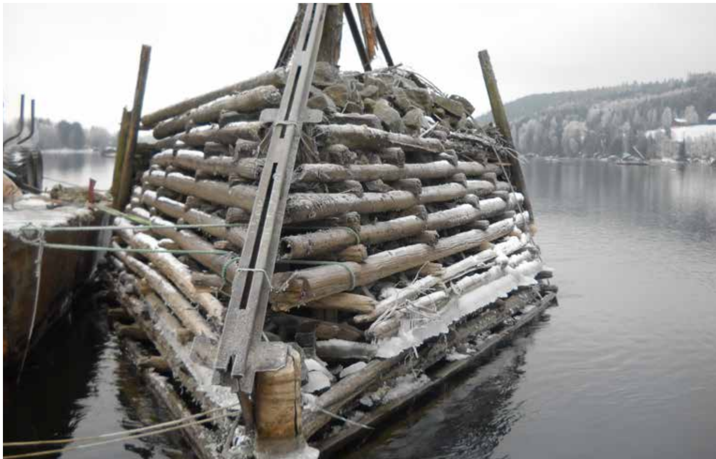
Tømmer, isgang og elvestrøm har slitt på laftestokkene. «Rieren» er forskjøvet. Foto: Ole-Kristian Hammeren
