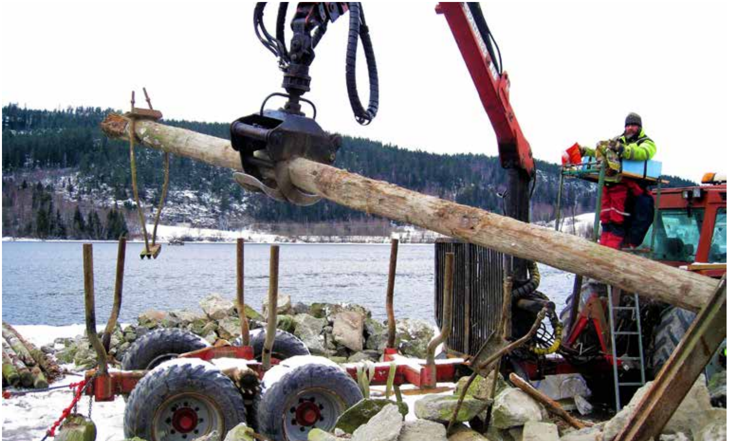
Tømmerkran i arbeid: Rolf Hammeren kjører tømmerkrana og løfter morkne stokker ut av karet. Foto: Nils U. Hagen
