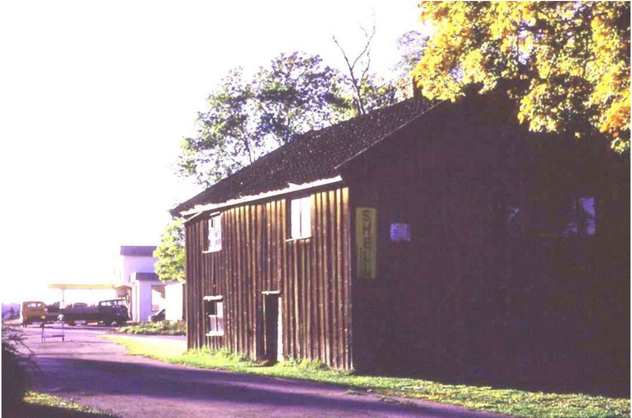
Korsegårdstunet. Skysstasjonen og skjenkestuen med Shell-merket på veggen. Stasjonen fra 1956 i bakgrunnen. Tatt i 1971. Foto Vidar Asheim
