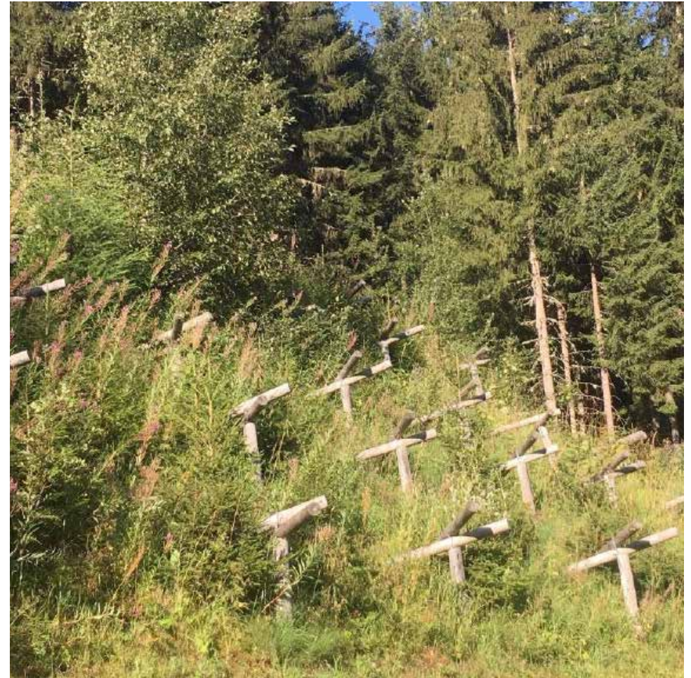
Figur 28: Eksempel på støttebein som må etableres i det potensielle utløsningsområdet.
