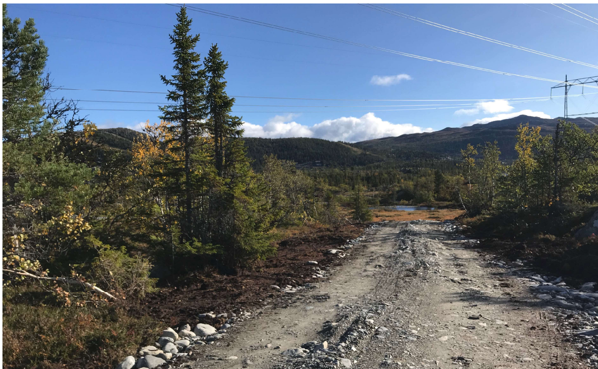
Fra "toppen" av Kilen mot Gaustablikk. Bildet viser hvordan det ser ut etter at stein er fylt på, og før pussing, bærelag og topplag. Ca. 18.000 m 3 stein må til for å bygge turveien.
