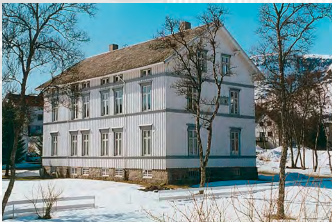
Den opprinnelige stasjonsbygningen
