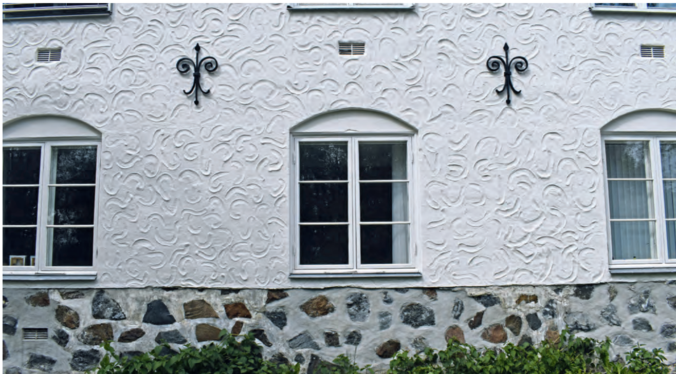
Utvendig gamle kjøkken
