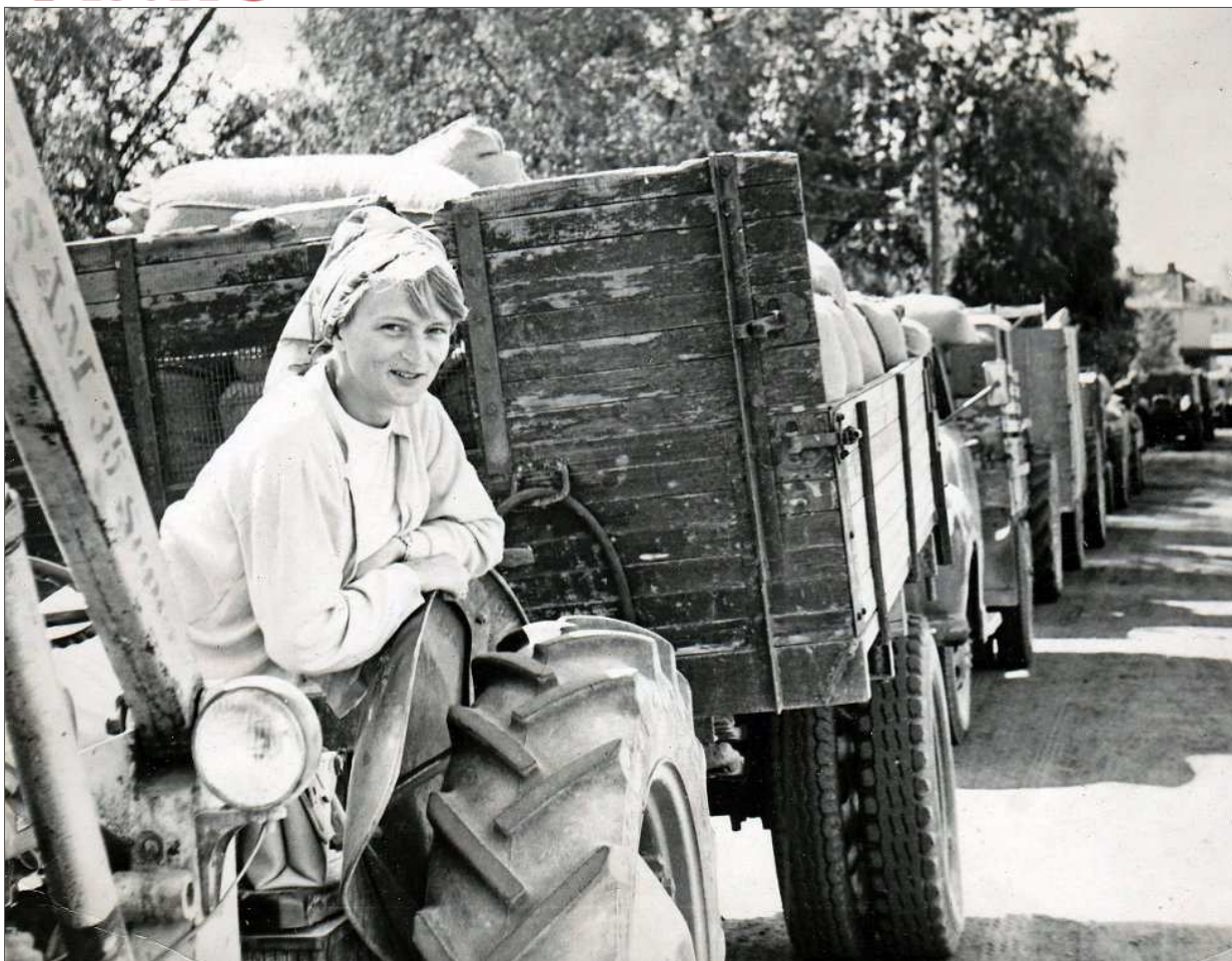
KØ TIL KORNSILOEN: Nes er Romerikes og et av landets største kornkammer. Anne-Lise Asdahl ventet på å få levere et traktorlass ved Årnes Kornsilø & Mølle.
