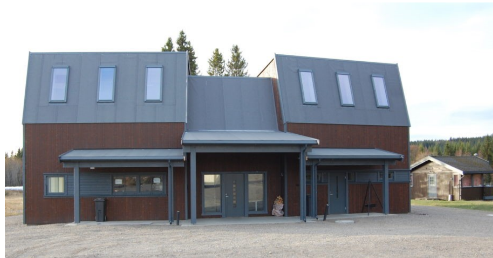
2018 Nytt stadionbygg med garasje og gode fasiliteter
