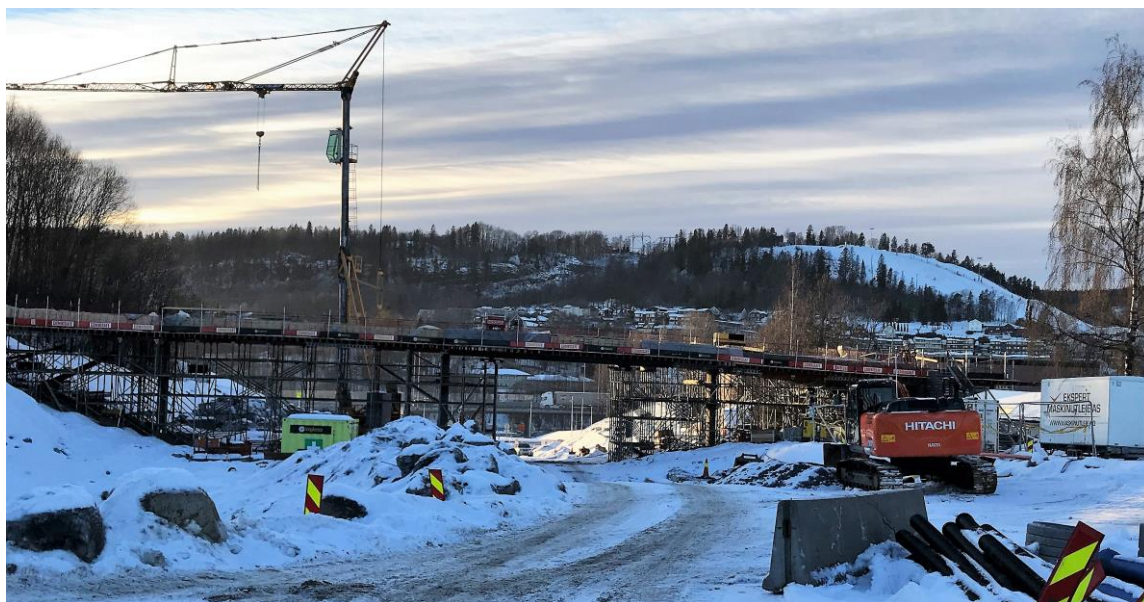
Fra en hektisk byggeperiode for ny E16. Nå er veien «til Rykkinn» klar. (foto: Erik Sennesvik)
