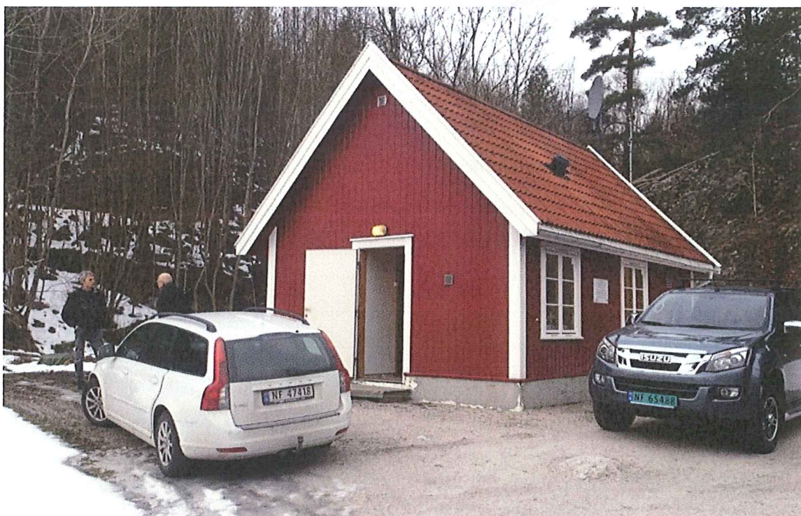
Figur 1 Betjening, el-installasjon og kjemisk felling skjer i bygningen, mens slamavskiller og utjevningstank ligger nedgravd ved siden av bygget.
