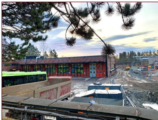
Parkeringen til bussene er blitt byggeplass
