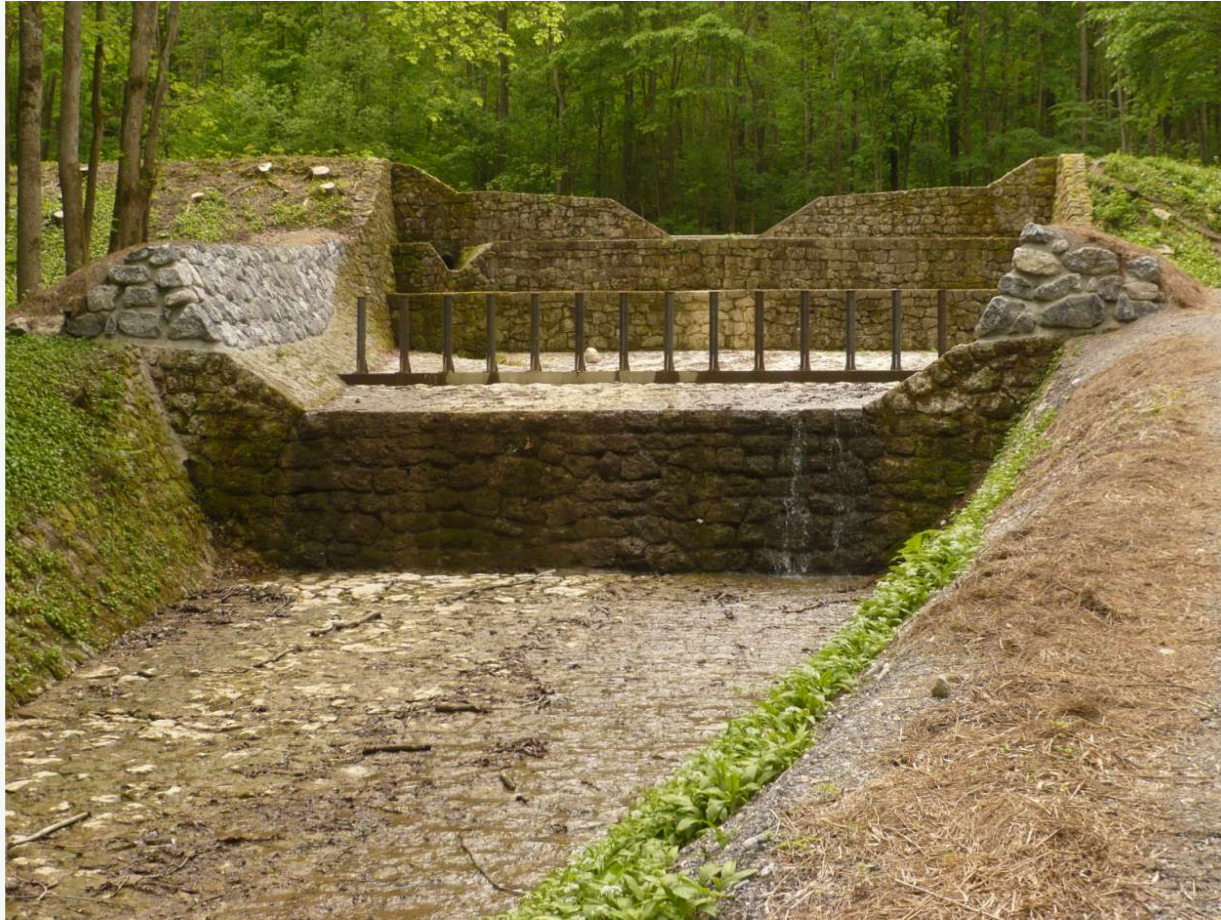
Flomdemper (vannbrems), sedimenteringsbasseng og oppsamler for rekved – Rosenberg, Bayern
