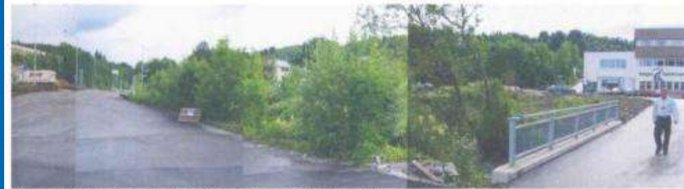
Fotoet viser dagens situasjon med det gjenvokste elveløpet ved gamle Midtun bro.
