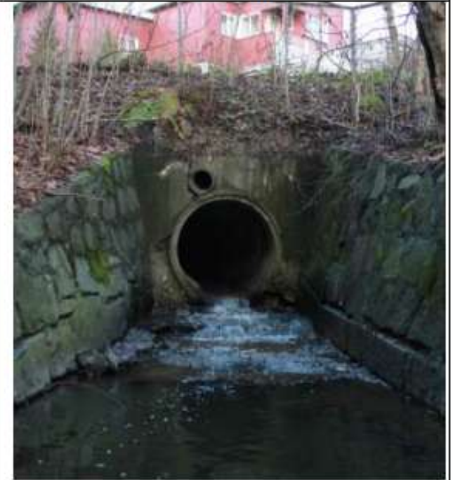
Bekkelukkinger og vandringshindre
