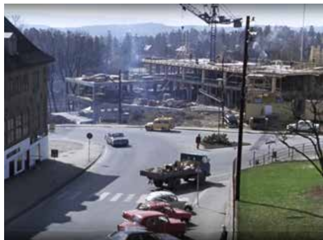
Andenæsgården under bygging
