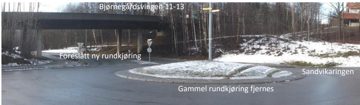
Ny rundkjøring under E16 broen som rives. Det muliggjør direkte adkomst til boligområdet.
