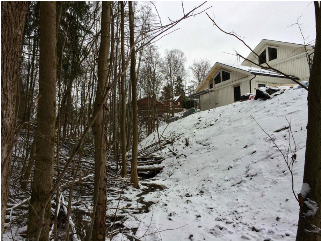
Utfylling og hogst ved Nadderudveien 68
