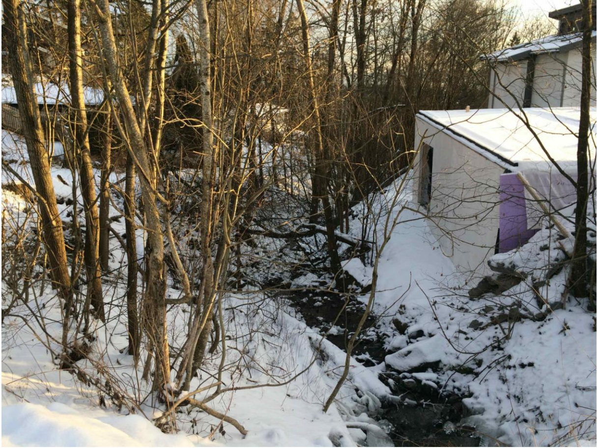
Nytt garasjeanlegg på Billingstadveien 105 som er bygget kloss inntil bekken
