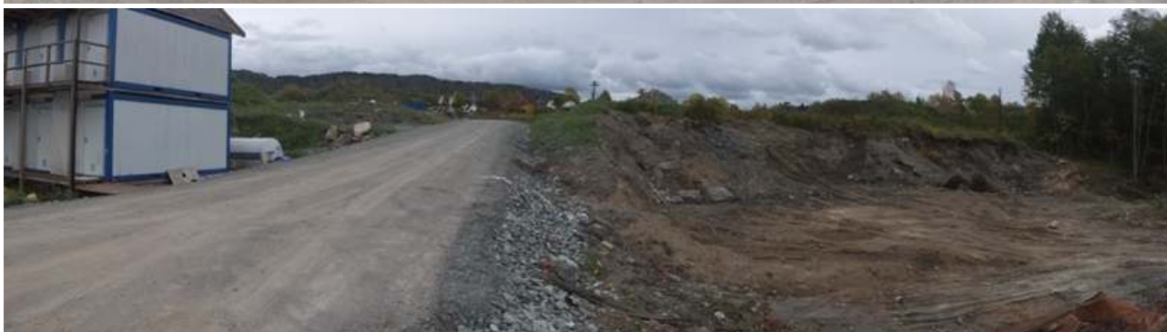
Fire panoramabilder av tidligere grøntbelte. Bilder ovenfra og ned 360 grader med klokken. Fra øst, syd, vest, nord og øst igjen. Masser er fjernet ved Bråtesprekkbekken til høyre nederste bilde.
