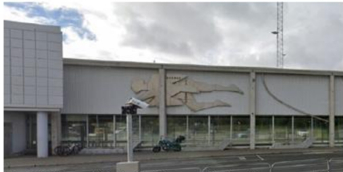
Figur 5 Eksisterende fasade/støyskjermer vest for hovedinngang med deler av kunstverket Vind og Stjerner utført av Johannes Block Hellum
