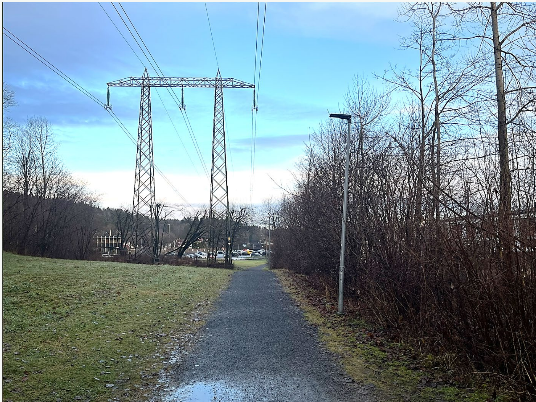
Blir ikke gravd ned før skolen er ferdig
