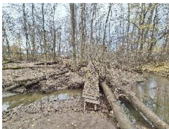
Flomskader ved Vøyenenga
