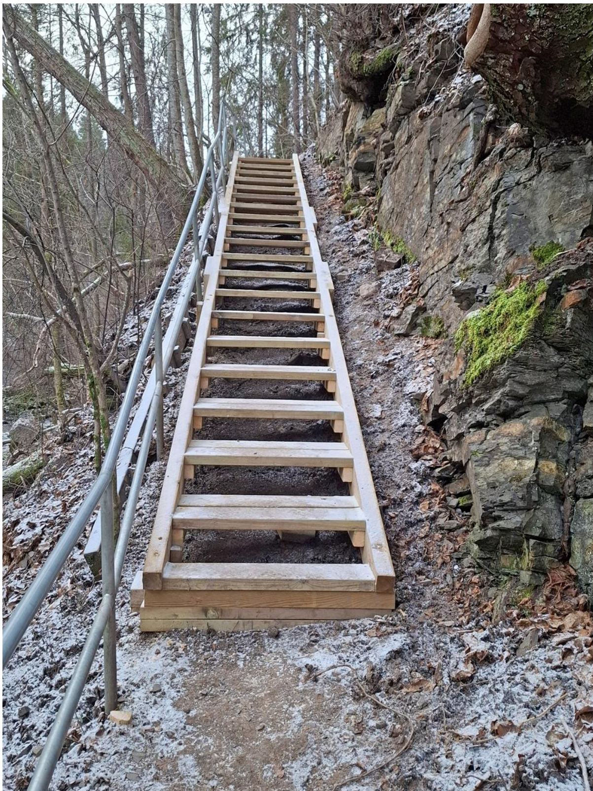
Ny trapp ved Sandbonn. Trappa mellom Sandbonn og gangbrua til Lysejordet ble byttet ut i høst og skrenten ved siden av ble renset for løse steiner. Denne er en av tre tretrapper langs turvei L-1 som byttes ut.
