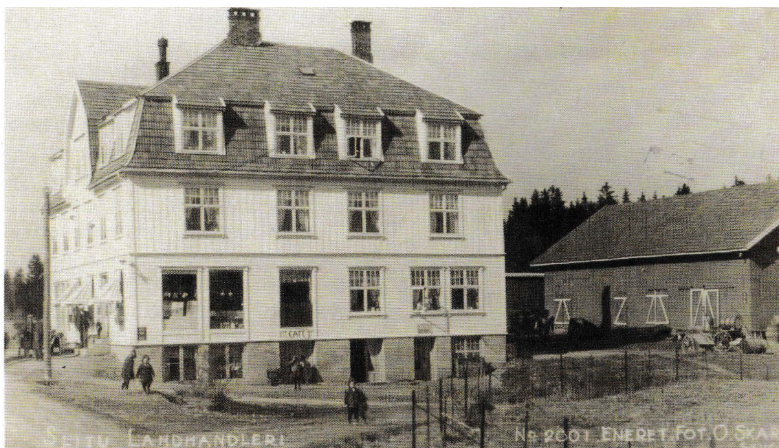
Slitugården inneholdt melkemottak, café, bakeri, landhandleri, postkontor samt sju leiligheter i 2. og 3. etasje. Gården ble skadet under spregningen Splinter fra banelegemet traff Slitugården En av dem gikk gjennom veggen og inn i soverommet i 2. etasje.
