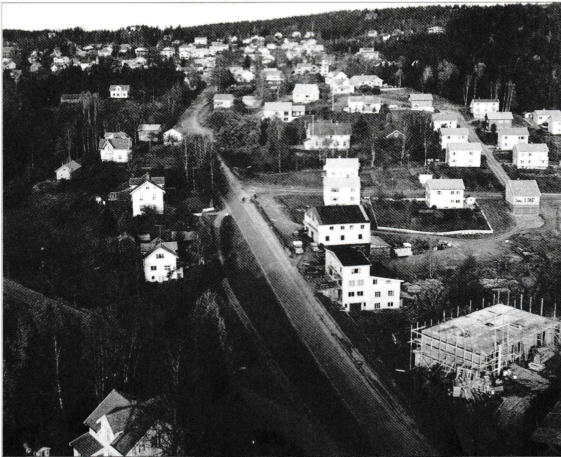
Nedre del av Vandugbakken sett fra kornsiloen. Lagerbygget til Hans S. Olsen til høyre under oppføring. Den tidligere silomesterboligen nede til venstre i bildekanten. Foto fra Indre Smaalenenes Avis.
