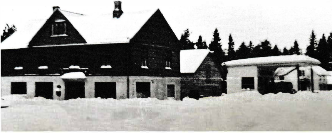
Momarken landhandel etter et stort snøfall etter at bensinstasjonen ble oppført. Lageret skimtes i midten. Foto utlånt av Bjørg Ellingsen.
