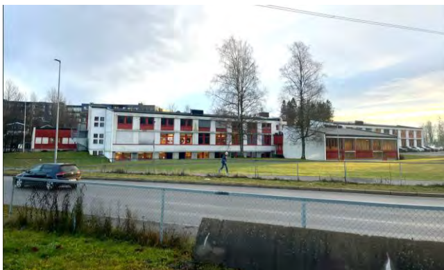
Figur 51: Skolebygget sett fra nord.
