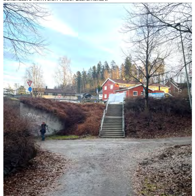
Figur 31: Problemområde nord for planområdet ved undergangen under Bærumveien. Her kan det samle seg vann ved store nedbørsmengder.
