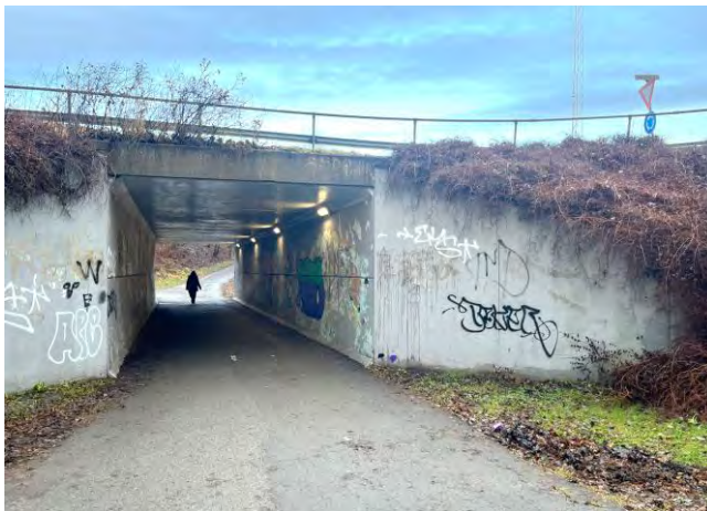
Figur 42: Undergangen under Bærumsveien sett fra sør.
