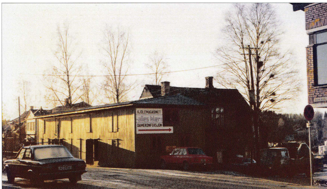
Fra hjørnet ved Arild's Stormarked i 1973 Lagerbygningen til Leif Mysen i David Blids gate. Nedenfor leiegården kalt «Blokkehuset». Bildet er utlånt av Ole Lauritz Mysen
