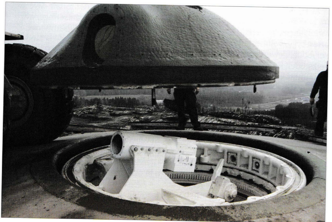
Montering av 7,5 cm tårnkanon på Høytorp fort.
