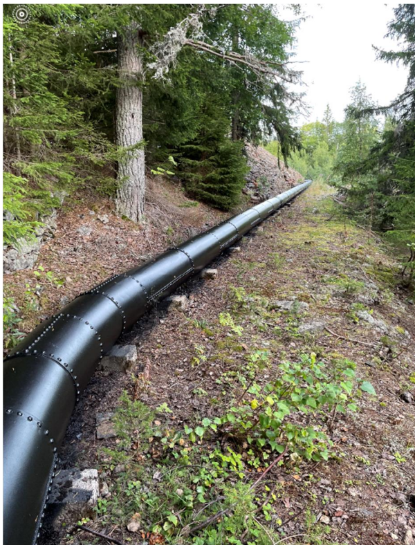
Rørledningen mellom Armengruvedam og Armen gruve ble høytrykkspylt og malt. Foto: Per Halvor Sælebakke
