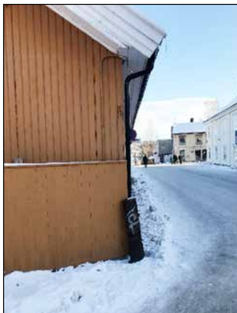
Malmrøret ved husveggen Maurits Hansens gate/Rogstadbakken med ventilhus av malmrør. Foto: Gunilla Thorsen.
