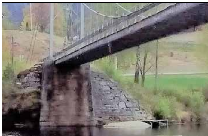
Komnes bru – fundament på vestsida.
