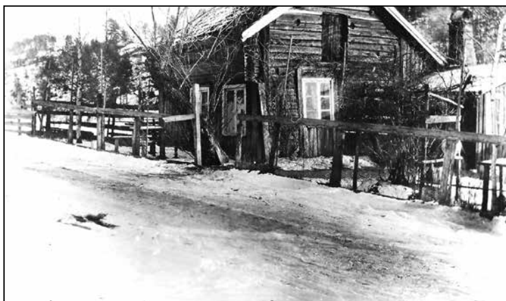
Bomstua på Gamle- veien/Bombakken/ Krakebakken.
