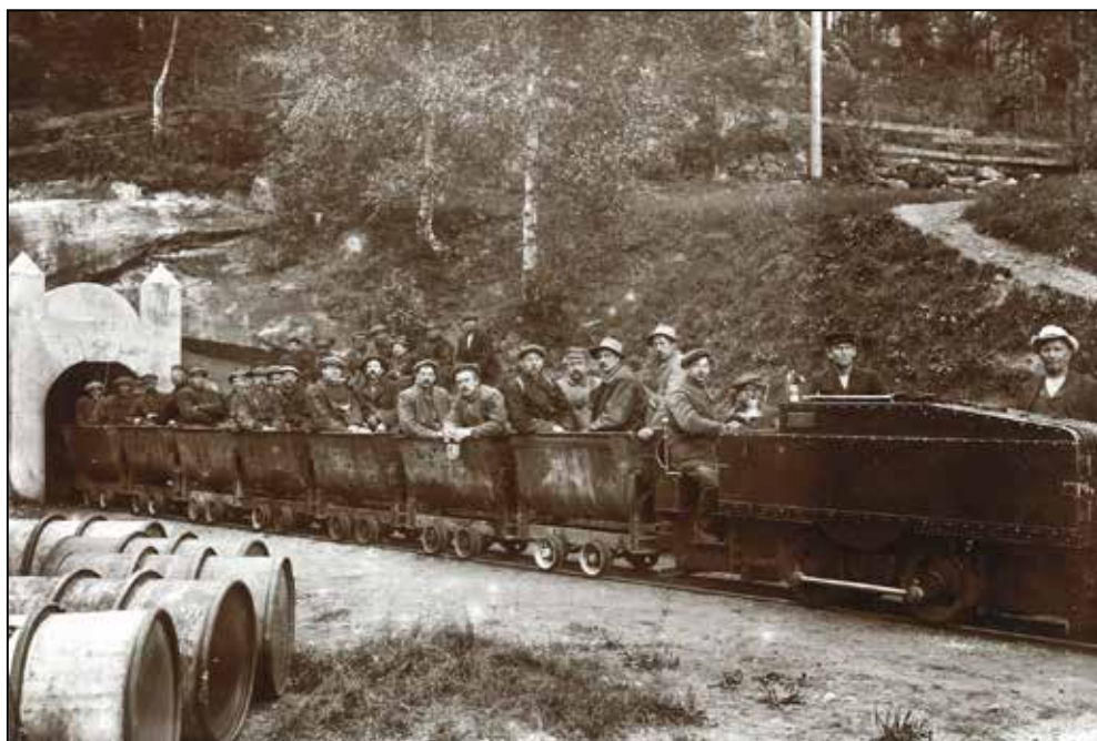
Tog med bensinlokomotiv, innført i 1912. Stollåpningen, «mundlochet», har årstallet 1721 og korslagt «Schlegel und Eisen». (Foto H. Dahl 1914, Norsk Bergverksmuseum)
