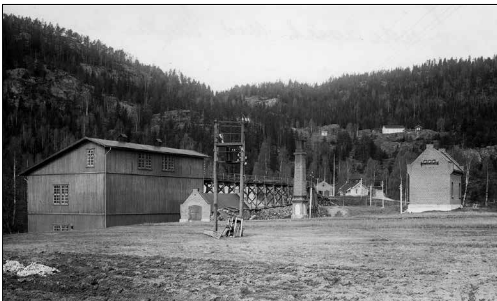
Anlegget utenfor stollåpningen slik det sto ferdig i 1913. T.v. sjeidehus, fyrhus for sentraloppvarming med pipe, trafo, lenger bak lokstall og kontorbygning. (Foto: Norsk Bergverksmuseum)
