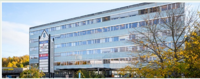
Over: I dette bygget på Bryn har LMK sine nye kontorer.
