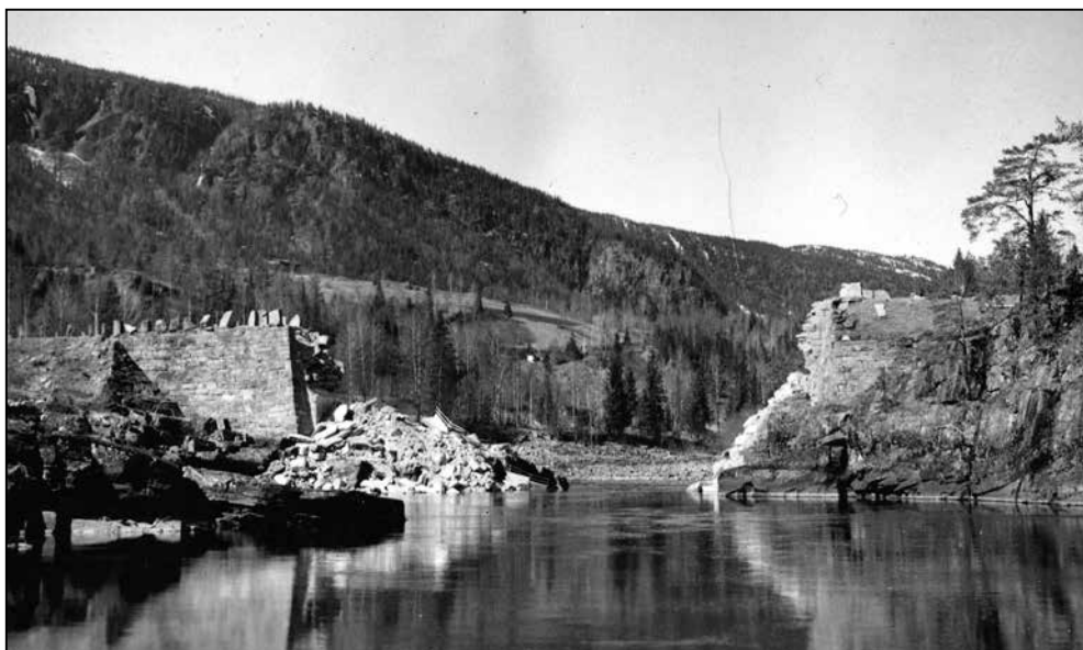
Mykstu bru sprengt. Kilde: Rollag fotoarkiv.
