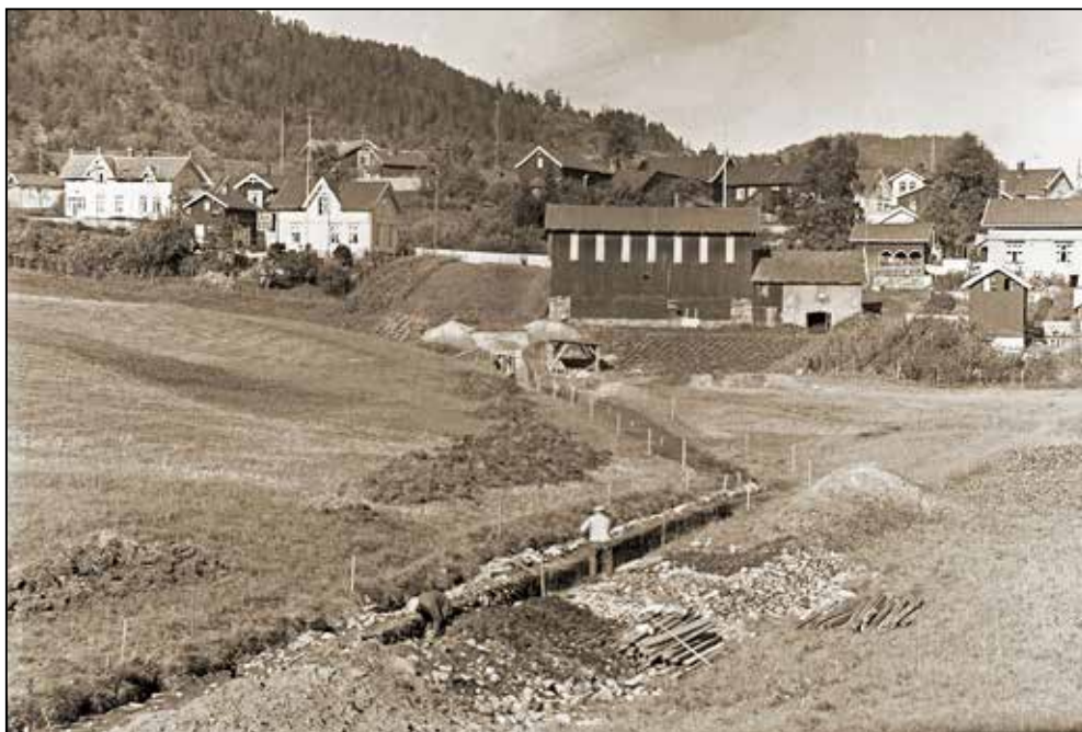
Kloakkledning/vannledning graves til Myrløkka. Foto: B. Willms, VSBs fotoarkiv.
