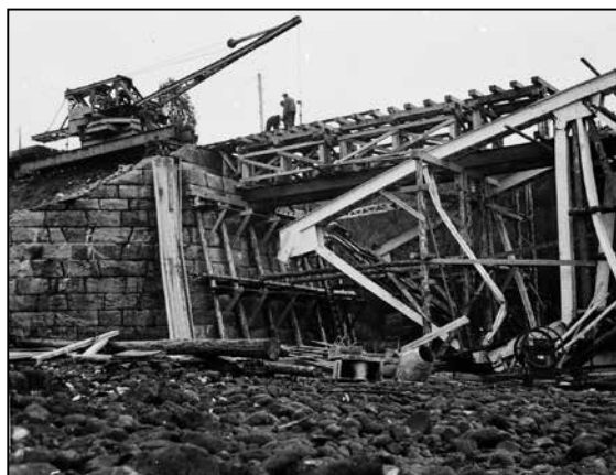
Bruhaug bru sprengt. Kilde: Rollag fotoarkiv.
