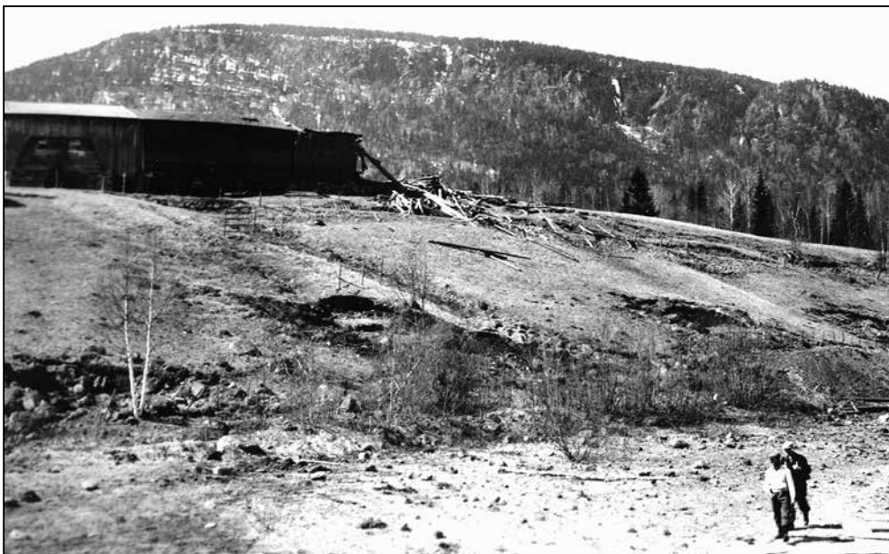
Nedre Mykstu, stallen sprengt. Rollag fotoarkiv.
