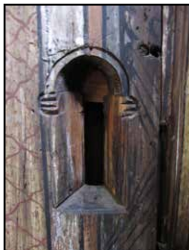
Nore stavkirke. To små vinduer på planke bevart fra middelalderen. Det øverste 38x22 cm. Det nederste 28x16 cm. Foto: Bjørn Haug Hanssen.
