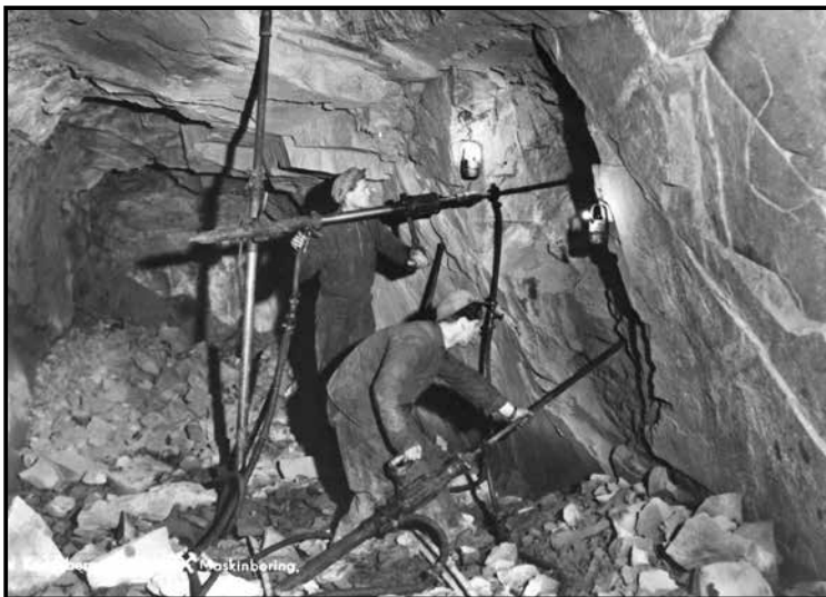
Sigurd Hagen og Reidar Saatvedthagen (i bakgrunnen) fotografert i forbindelse med utsprenging av evakueringsrommene i Kongens gruve ca. 1943. Motivet inngikk også i en fotomappe med bilder fra Sølvverket. (Postkort).
