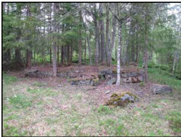
Viermyrstua pr 2017. Kun grunnmurer igjen. Foto: Anders Lundeberg.
