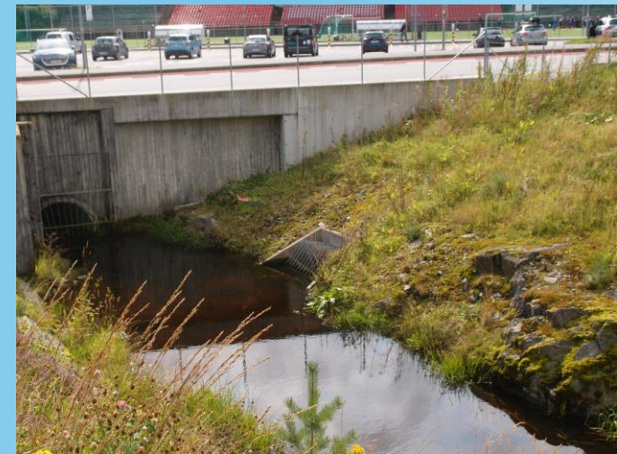
Utløp overvann fra idrettsanlegget
