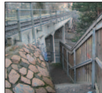
Broen over Ostadalsveien og trappen ned fra Røa Barnehave.
