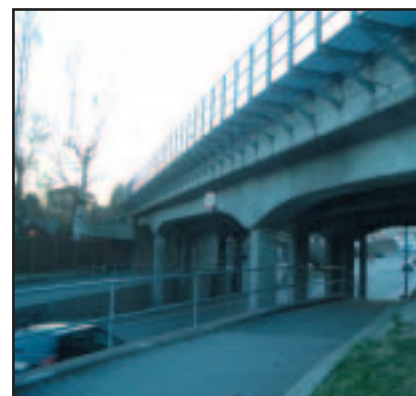
Broen over Sørkedalsveien.
