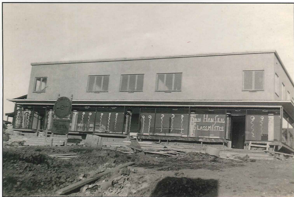
Under byggingen av Røa Handelsforening
