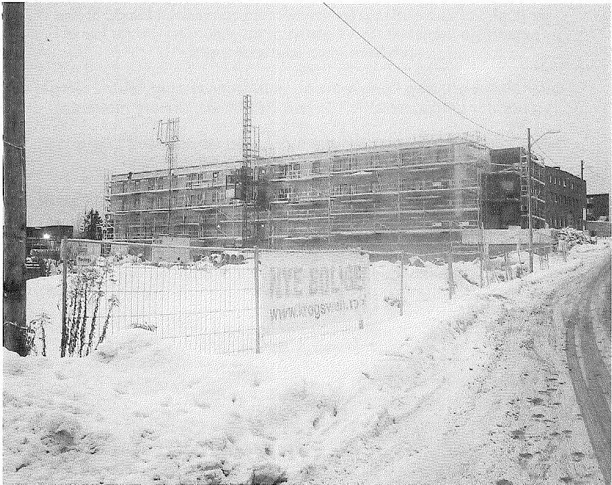
Nye boliger under oppføring i Aslakveien
