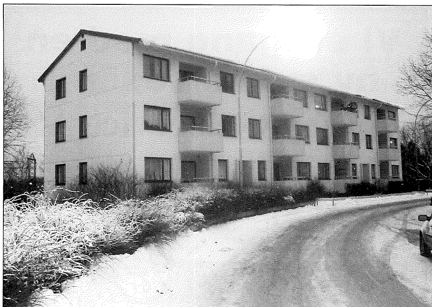
Typisk Røa-blokk: Porfyrveien
