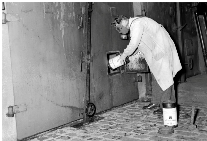
Bilde: Dampdesinfeksjon på 100 grader ødela mange gjenstander, og ble derfor erstattet med kjemisk formaldehyd-desinfeksjon på bare 40 grader. Fra Helserådets desinfeksjonsanstalt i Heimdalsgata i 1950. Foto: Arbeiderbevegelsens arkiv og bibliotek.
