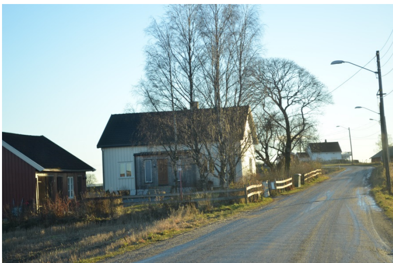
Bildet er tatt i 2012 og dette er altså den første faste skolebygningen i Fet.
