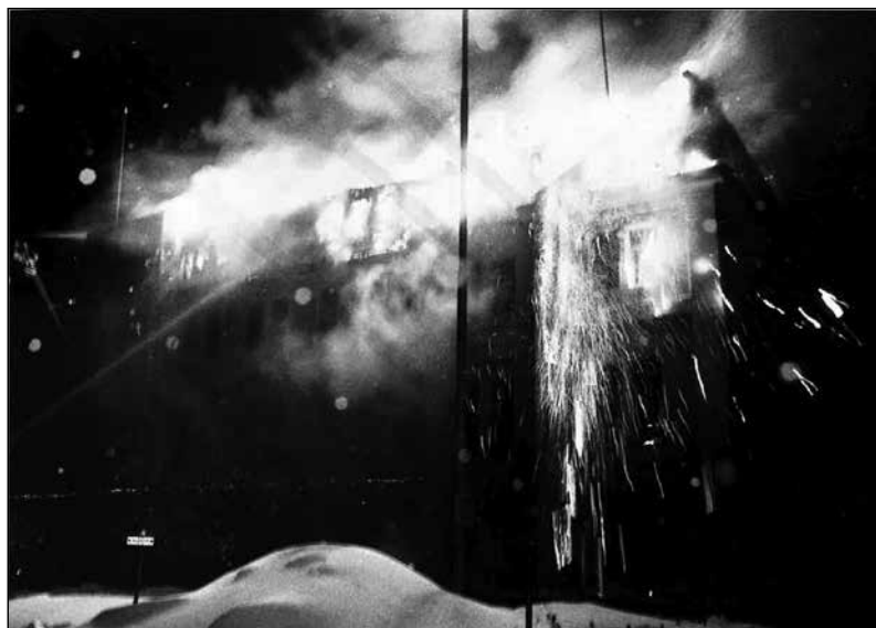
Rådhusbrannen, en sammenrotting av ild, is og mørke. Foto: Laaagendalsposten.
