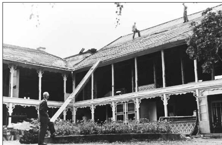
Da Grand hotell ble revet i 1962 var det fortsatt formålstjenlig å ta ting pent ned og bruke det på nytt. «Snekkergleden» på verandaen er fjernet, takstein er tatt vare på. Frisørmester Hvamb betrakter arbeidet. KH 2289.
