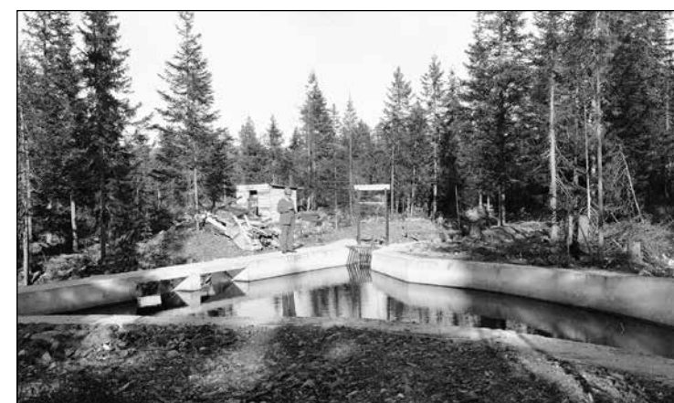
Inntaket i Kunstbekken brakte mye vann til Rundetjern når det regnet. Men det gjorde det ikke alltid. OM 253.
