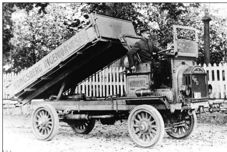
Kommunens ingeniørvesen er motorisert! Sjøfører Christian Mikkelsen troner på kommunens første lastebil ca 1915, som har tipp og til og med er firehjulsdrevet – FWD. Det fremtredende merket på grillen ble på fokemunne utlagt som «faens vandr-ende dass», for engelskkunnskaper var mangelvare. KH 1771.
