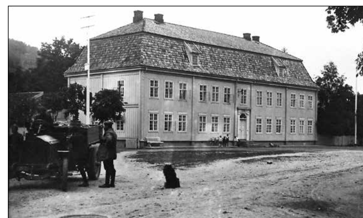
Bergseminaret, Norges første tekniske høyskole. Det har uendret utseende fra det var nytt, bortsett fra fargen. KH 2277.
