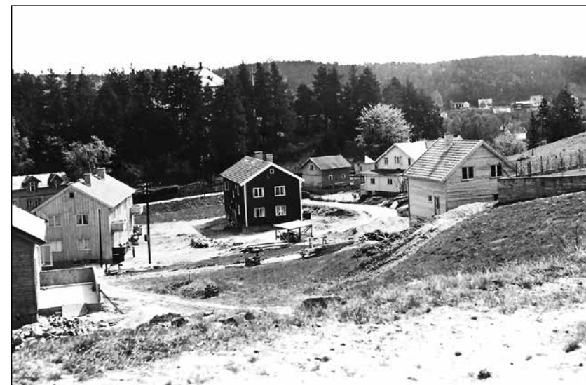
Tre rom og kjøkken, bad og klosett på Myhrløkka ca 1953. KH 2780.
