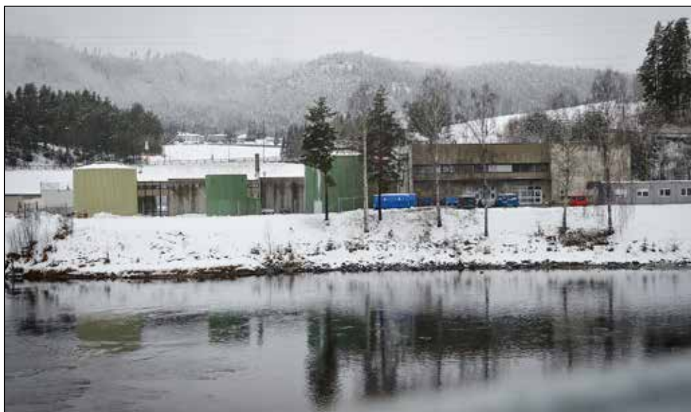
Nytt renseanlegg i Selliksdalen. Foto: Laagendalsposten.
