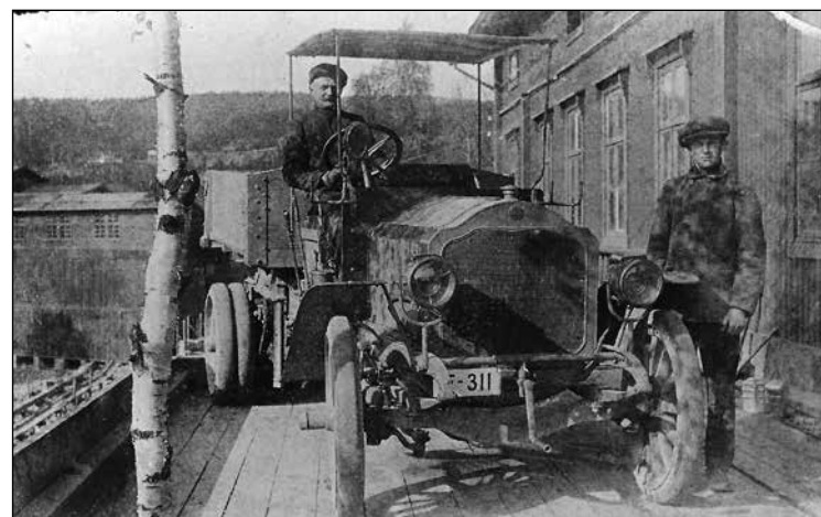
Sølvverket motoriseres. Gustav Østby kjører verkets Lorraine-Dieterich lastebil med tipp, mens Thorolf Fusche bivåner. Bilens vekt var 2,5 tonn, vekt med fullt lass 5,0 tonn, og den var innkjøpt i 1913 for kr 13 000,-. Årslønna for en bergmann på denne tida var til sammenligning ca kr 1 100,-. Bilen gikk på bensin, med toppfart 18 km/t, største stigning med fullt lass 1:5, motorkraft 20-30 hk. Den hadde kompakte gummihjul, som førte til at vinduer klirret og nips danset cha-cha-cha på hyllene når den kjørte forbi med lass fra Underbergstollen til Saggrenda. KH 1780.
