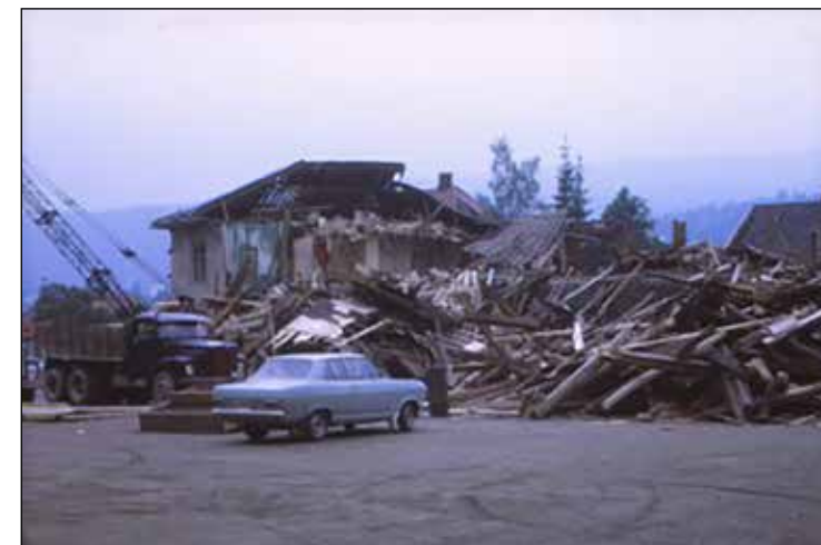
Den nye tid er kommet til Kongsberg. Verden er stuvende full av ressurser som bare venter på å bli brukt, og av gammelt ræl som knapt fortjener skraphaugen. «Samfundet» ble revet med grave-maskin og dumpet på fyllinga. Foto: Oddvar Antonsen.
