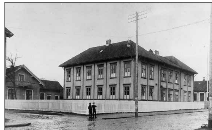
Nymoen skole som forholdsvis nybygget, rundt 1900. Korvald 046.
