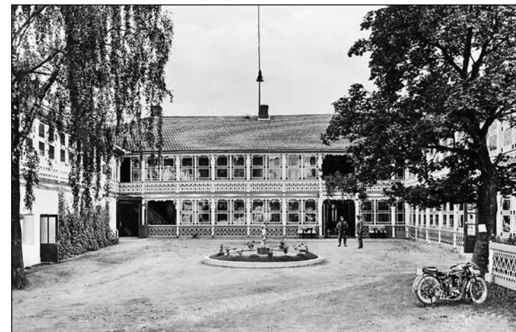
Grand hotell, etablert i 1895 og byens beste, her gårdsplassen rundt 1915. Utskjæringene ble framstilt maskinmessig og kunne kjøpes i metervis – «snekkerglede» kaltes de. KH 393_4.
