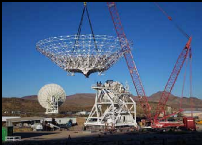
KRONEN PÅ VERKET: DSS-23 i California ble «kronet» med den 34 meter vide og 133 tonn tunge primærreflektoren i desember 2024.
