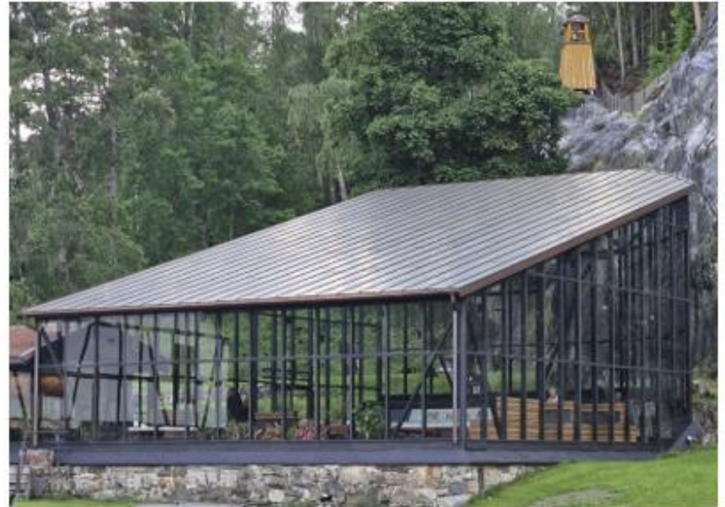
Bilde 2 - Glasspaviljongen med nytt tak i koppar.
