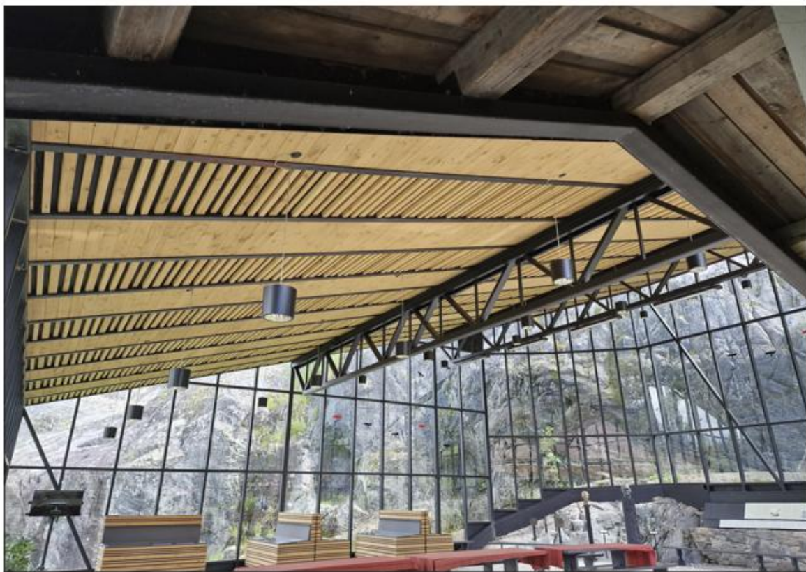
Bilde 3 – Trehimlingen med trefiberisolasjonen.
