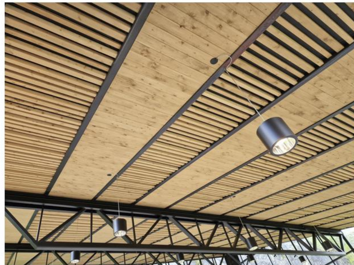
Bilde 4 – Trefiberisolasjonens akustiske egenskaper eksponeres der det er avstand mellom trespilene.
