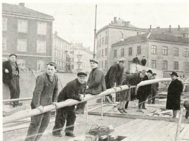
Masten prøvebelastes i horisontal stilling uten understøtning for oppheising.
