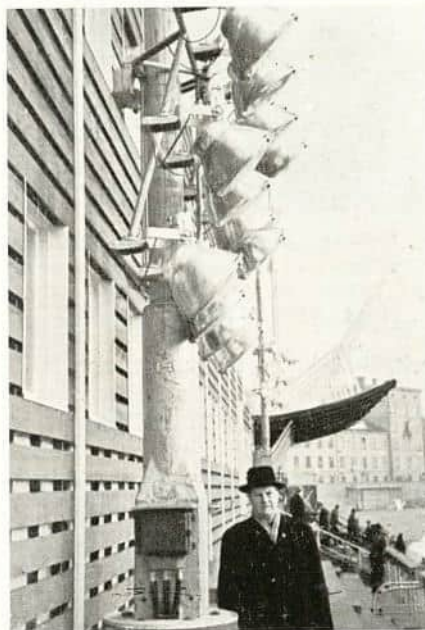
Nedheist stativ med 12 Westinghouse lyskastere. Ved siden overingeniør R. Eger.
