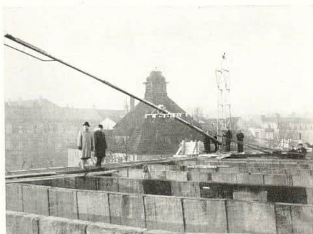
Reising av mast (plasert i bakkant av taket over tribune) ved hjelp av spesialkonstruert reisemast festet til stålstoefoten.
