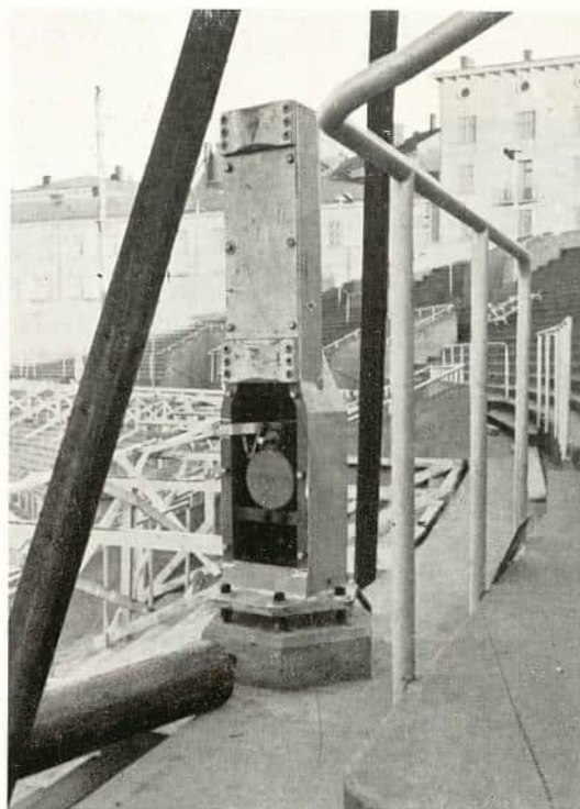
Mastefoten av stålstøpegods hvor man ser heiseanordningen og toppen av fundamentet.
