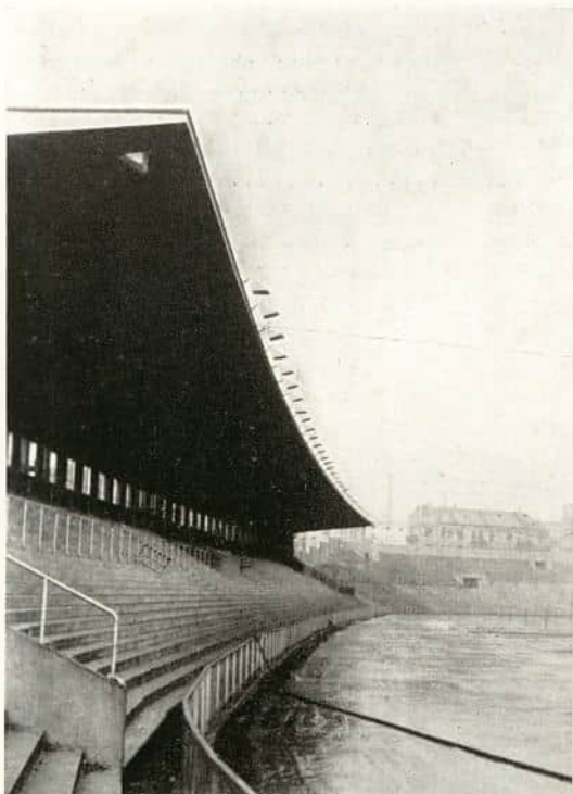
De 30 skrå lysarmaturer i forkant av tak over tribune. Disse har til oppgave å oppheve skyggene som taket bevirker på banen for lyset fra mastene (plasert på taket og i bakkant av dette).
